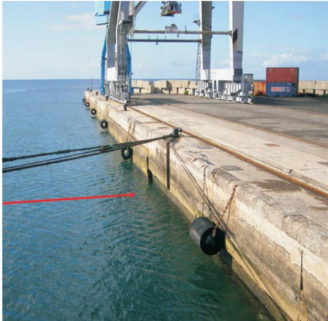
*En la foto se aprecia el desplazamiento de los bloques de hormigón.*
