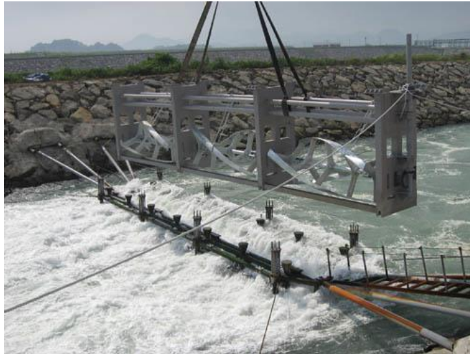
Imagen 63: Detalle de instalación de una turbina Gorlov horizontal en Korea del Sur.
