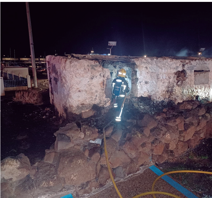
INCENDIO VIVIENDA ABANDONADA - YAIZA
