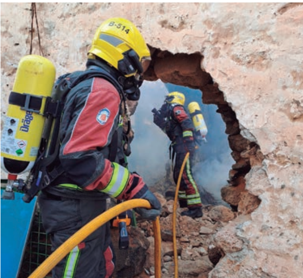
Incendio vivienda abandonada. Calle Blas Cabrera Topham, Arrecife.
