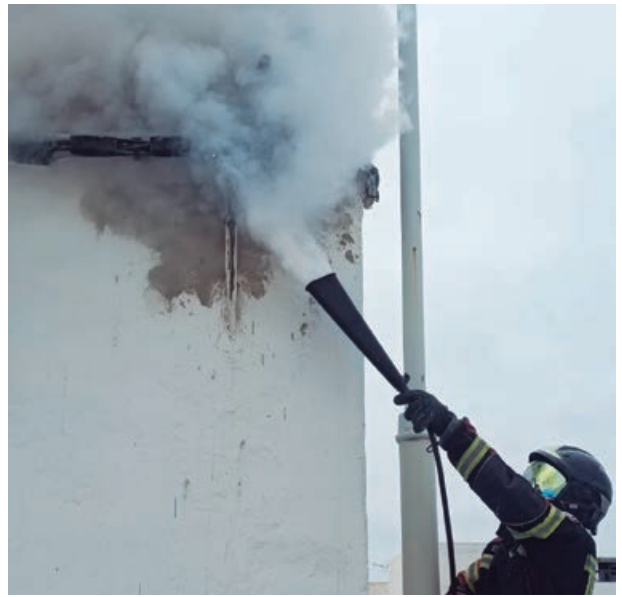
Incendio de cableado. Avenida El Marinero. Caleta de Famara, Teguiise.
