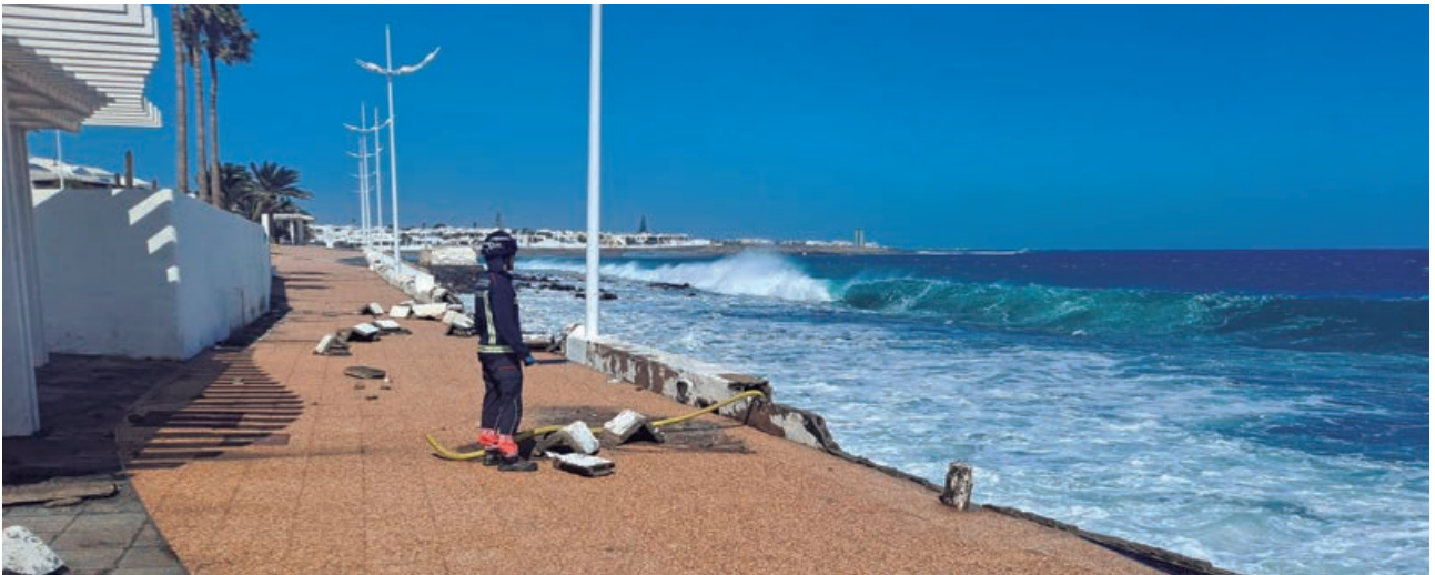
Asistencia derrumbe de muro. Avenida Playa Honda, San Bartolomé.
