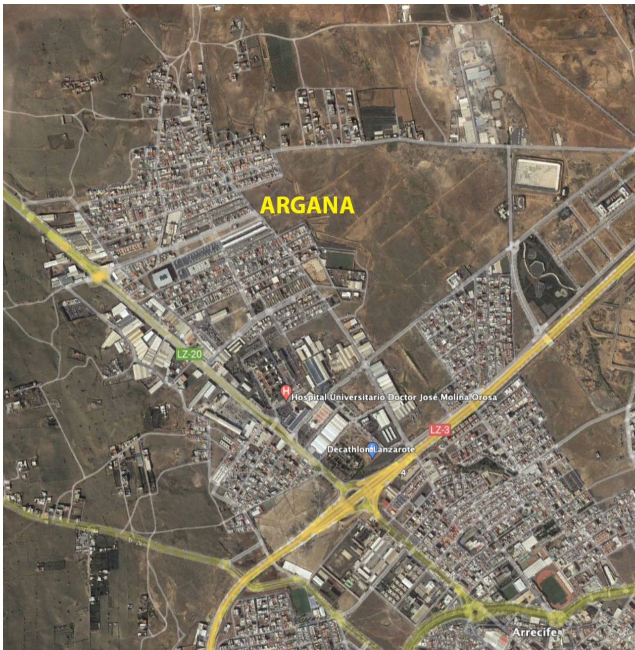
Enlace LZ-3 con LZ-20. Acceso a Hospital Universitario y barrio de Argana
