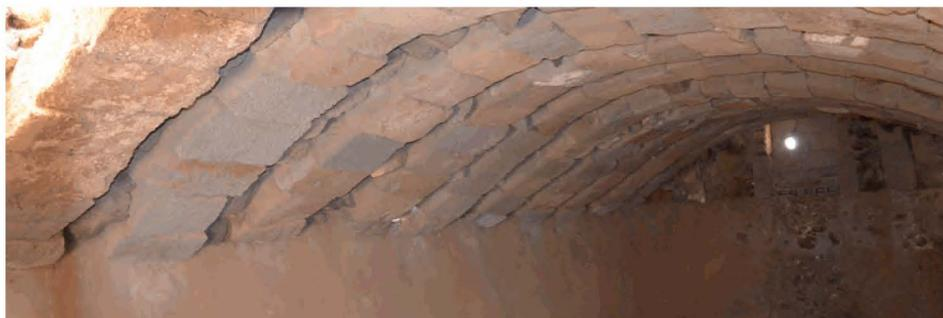
Los techos de los aljibes eran en general abovedados, realizados en cantería (basalto), se remataban con un brocal que es el hueco por donde se extrae el agua y un escurridero para captar el agua que cae sobre la cubierta. Los aljibes también contaban con una salida, el aliviadero o rebosadero por donde salía el agua en el caso de que se llenara.
