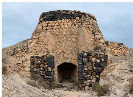
Los hornos de cal son construcciones cónicas o troncocónicas, hechas de piedra y barro. En la parte inferior hay una entrada para acceder al emparrillado de hierro que es donde se soportan las capas de piedras de cal y la leña y la colocación de las mismas se realizaba desde una apertura superior a la que se accedía mediante una rampa.
