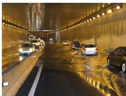
Ilustración 10. Túnel inundado en la isla de Gran Canaria
