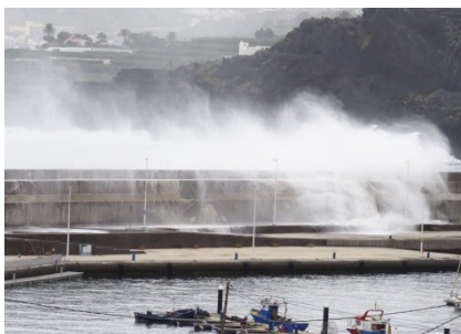
Ilustración 8. Puerto de Tenerife afectado por fuerte oleaje
