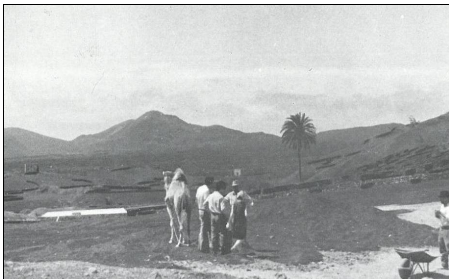
Preparación de un enarenado artificial. Distribución del estiércol.
