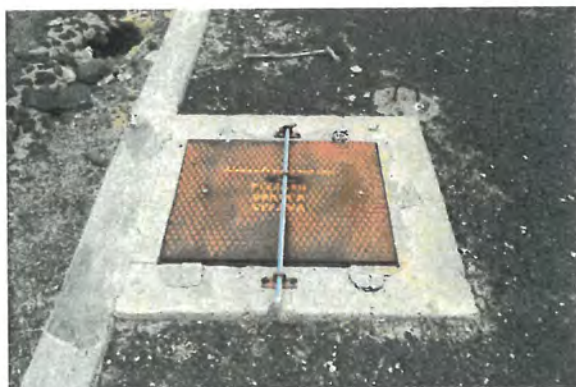
FOTONº2 VISTA DEL BROCAL
