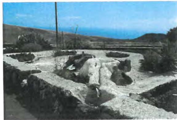
FOTONº1 VISTA GENERAL DEL ALJIBE
