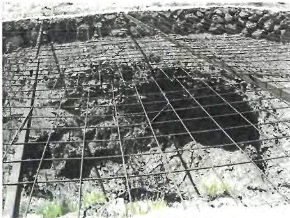
FOTONº2 VISTA DEL BROCAL
