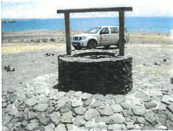
FOTONº2 VISTA DEL BROCAL
