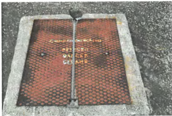
FOTONº2 VISTA DEL BROCAL
