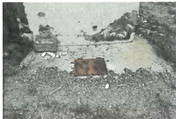
FOTONº3 VISTA DEL BROCAL
