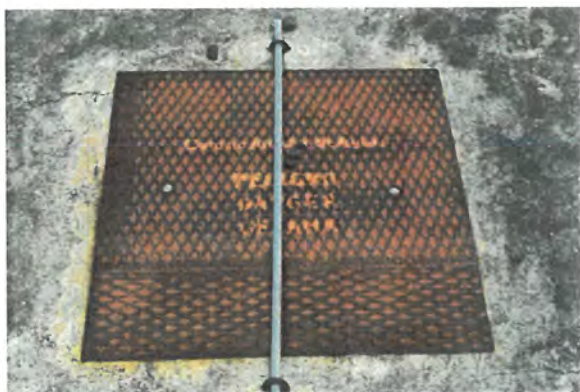
FOTONº2 VISTA DE BROCAL
