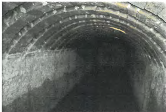
FOTONº3 VISTA INTERIOR DEL ALJIBE
