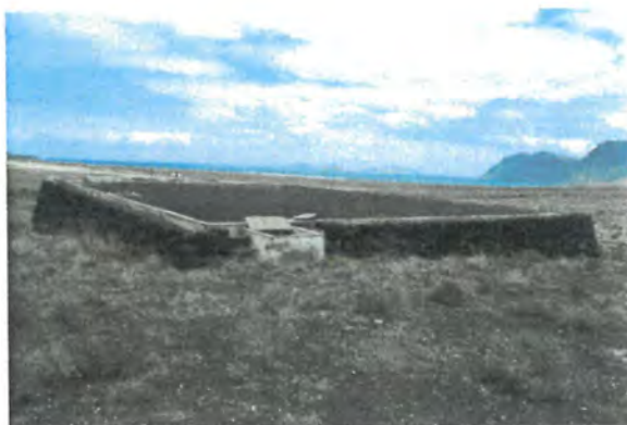
FOTONº1 VISTA GENERAL DEL DEPOSITO
