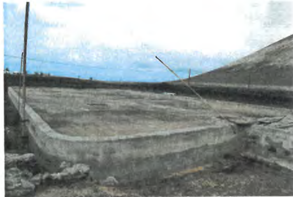
FOTONº1 VISTA GENERAL DEL ALJIBE
