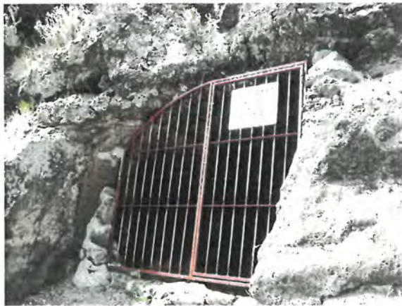
FOTONº2 VISTA DE LA ENTRADA
