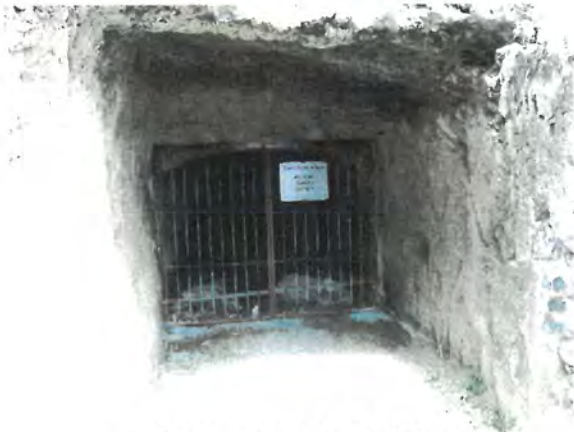
FOTONº2 VISTA DE LA ENTRADA
