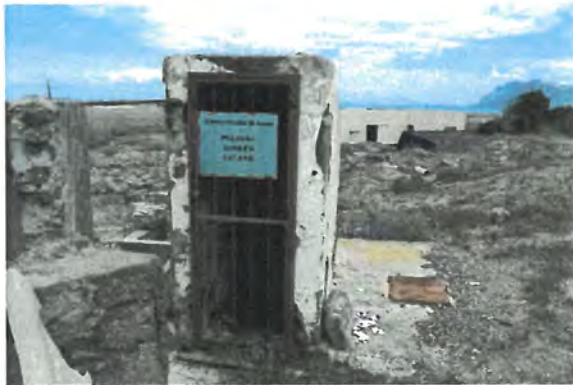
FOTO Nº2 VISTA DE LA PUERTA DE ACCESO AL POZO
