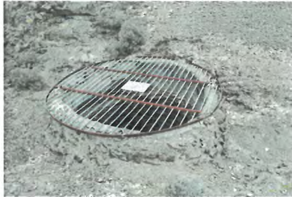
FOTONº1 VISTA DEL POZO
