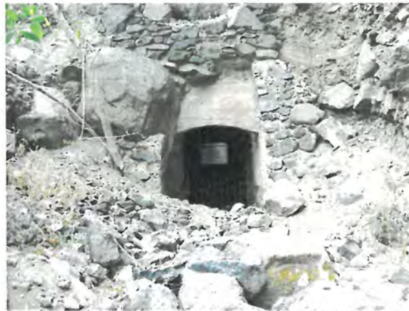
FOTONº1 VISTA GENERAL DE LA GALERIA
