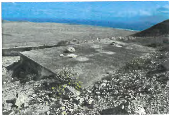
FOTONº2 VISTA DE LOS BROCALES HORMIGONADOS
