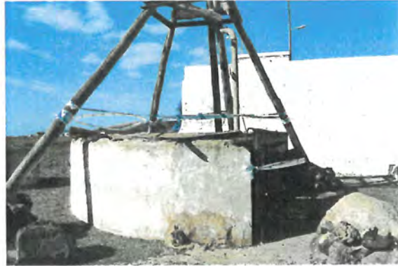
FOTO N°1 VISTA DEL POZO PRECINTADO
