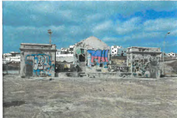
FOTONº1 VISTA GENERAL DE LA INSTALACION
