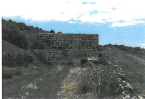
FOTONº1 VISTA GENERAL DE LA INSTALACION
