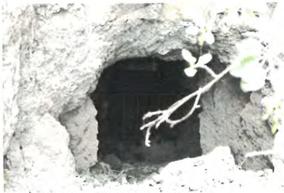
FOTONº2 VISTA DE LA ENTRADA
