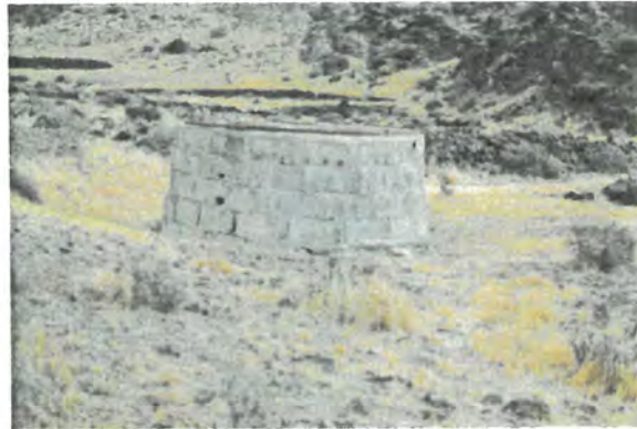
FOTONº1 VISTA GENERAL DEL POZO
