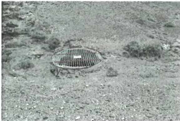
FOTO Nº2 VISTA DEL POZO
