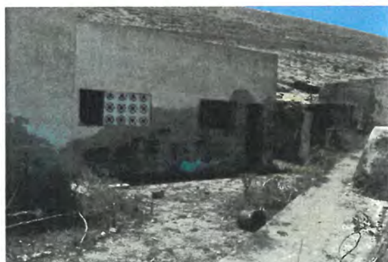
FOTO Nº2 VISTA DEL DEPOSITO Y DE CUARTO DE BOMBAS
