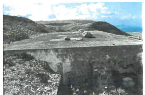
FOTONº3 VISTA LATERAL DE LA INSTALACION
