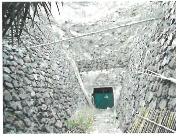
FOTONº1 VISTA GENERAL DE LA GALERIA
