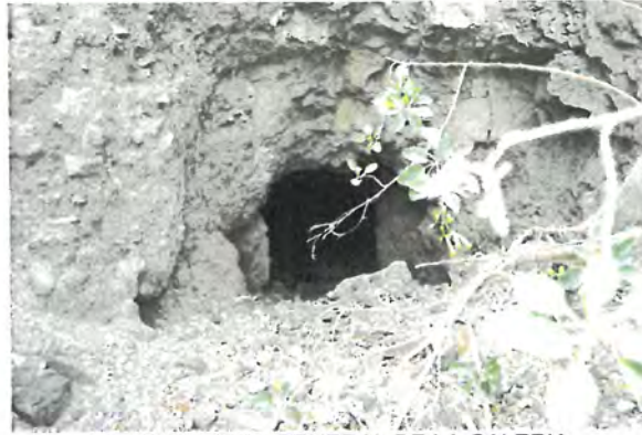
FOTONº1 VISTA GENERAL DE LA GALERIA
