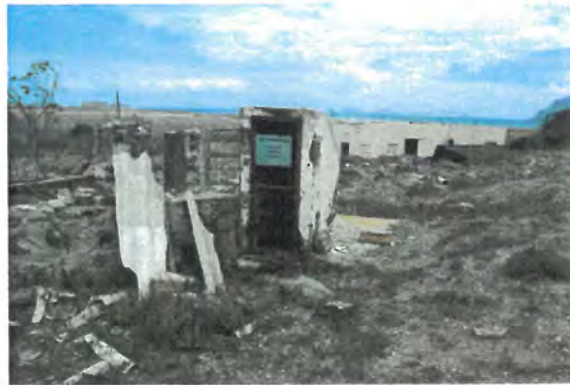
FOTONº1 VISTA GENERAL DEL POZO Y BROCAL
