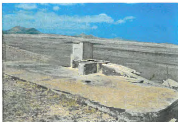
FOTONº1 VISTA GENERAL DEL DEPOSITO
