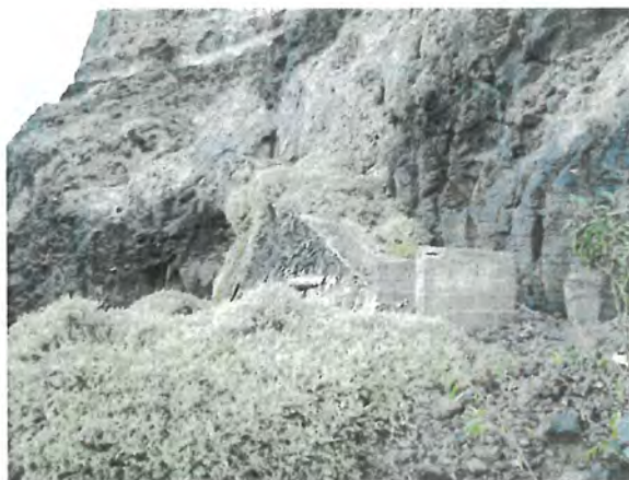
FOTONº1 VISTA GENERAL DE LA GALERIA
