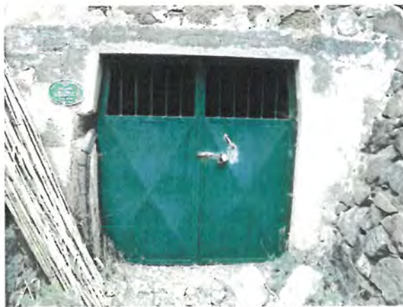
FOTONº2 VISTA DE LA ENTRADA
