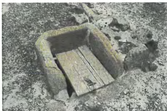
FOTO N°2 VISTA DEL BROCAL
