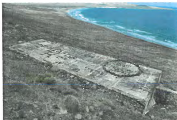
FOTONº1 VISTA GENERAL DE LA INSTALACION
