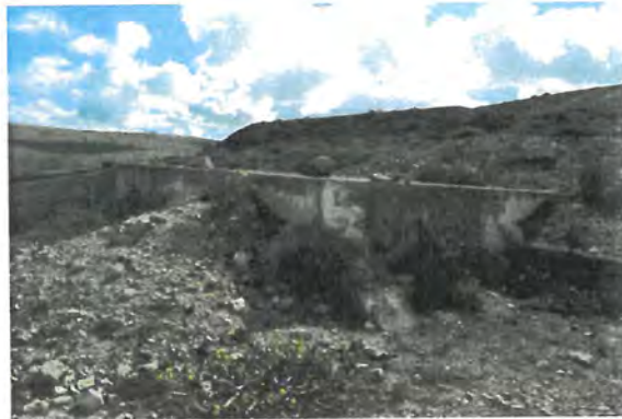
FOTONº1 VISTA GENERAL DEL DEPOSITO
