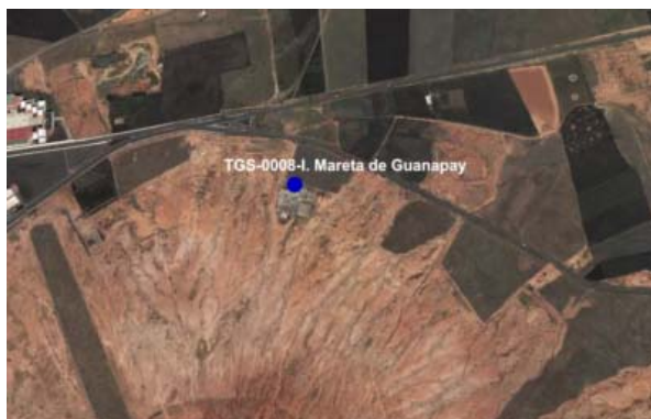
Detalle 24. Vista aérea de la instalación.
