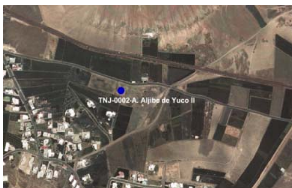
Detalle 61. Vista aérea de la instalación.
