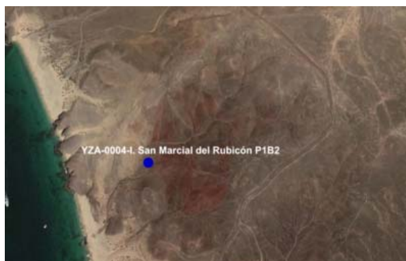
Detalle 51. Vista aérea de la instalación.
