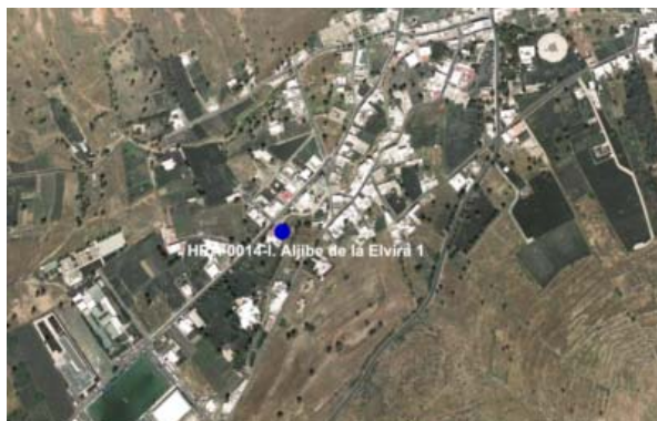
Detalle 41. Vista aérea de la instalación.
