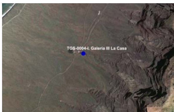
Detalle 20. Vista aérea de la instalación.
