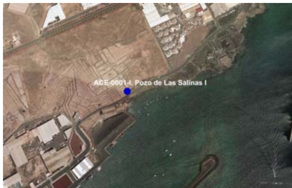
Detalle 1. Vista aérea de la instalación.
