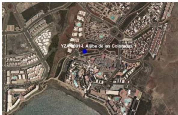
Detalle 48. Vista aérea de la instalación.
