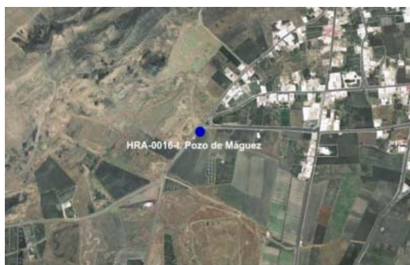
Detalle 43. Vista aérea de la instalación.
