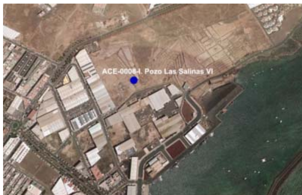
Detalle 8. Vista aérea de la instalación.
