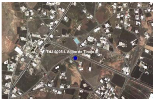
Detalle 64. Vista aérea de la instalación.
