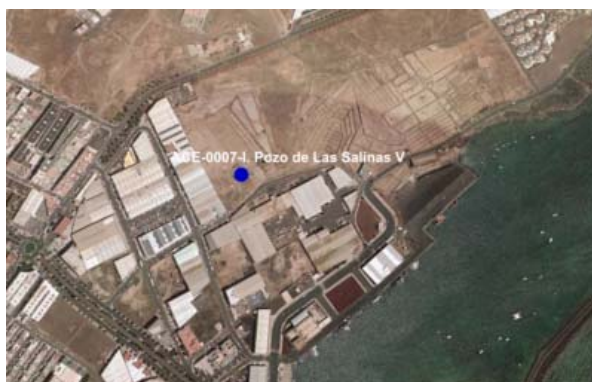
Detalle 7. Vista aérea de la instalación.
