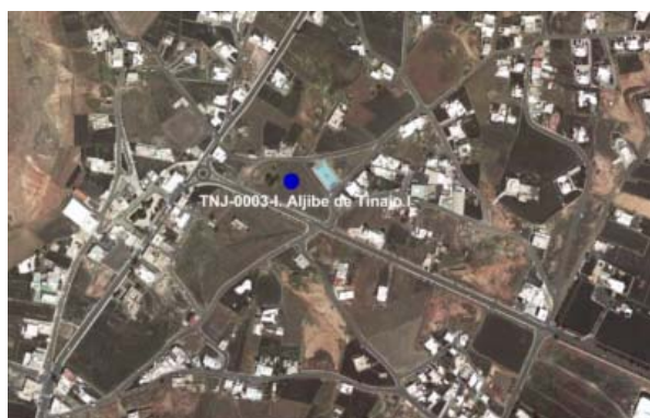
Detalle 62. Vista aérea de la instalación.
