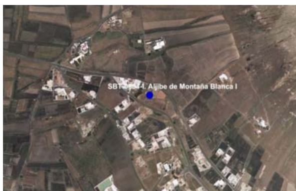
Detalle 15. Vista aérea de la instalación.
