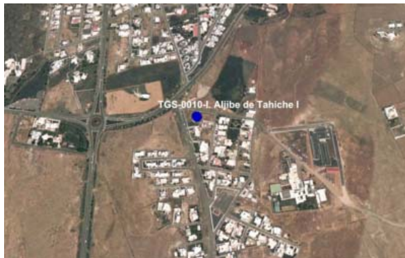
Detalle 26. Vista aérea de la instalación.
