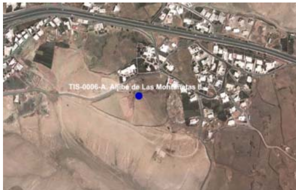
Detalle 74. Vista aérea de la instalación.
