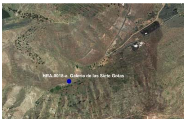
Detalle 45. Vista aérea de la instalación.
