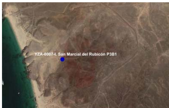
Detalle 54. Vista aérea de la instalación.
