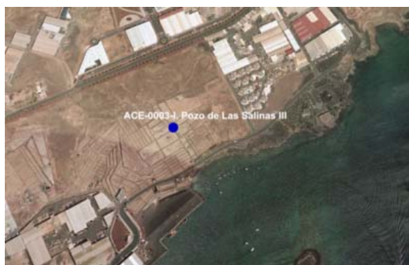
Detalle 3. Vista aérea de la instalación.
