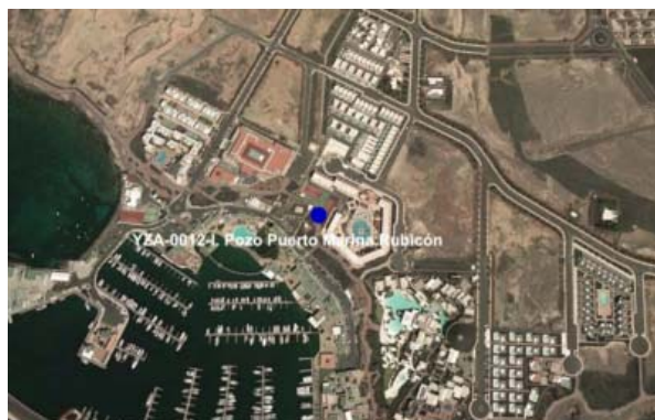
Detalle 59. Vista aérea de la instalación.
