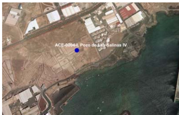
Detalle 4. Vista aérea de la instalación.
