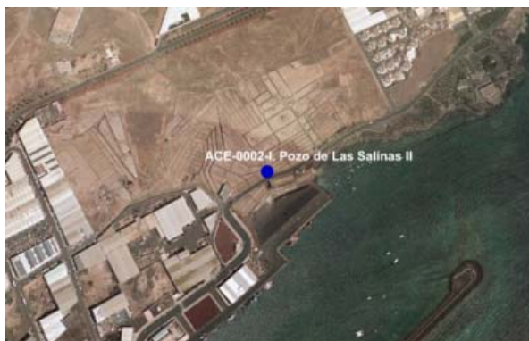
Detalle 2. Vista aérea de la instalación.
