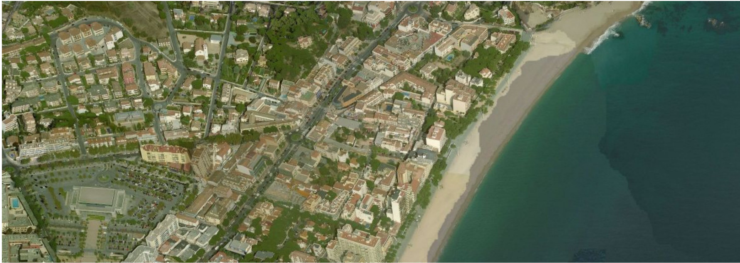
Figura 73. Vista aérea de las viviendas indultadas en la primera línea de Platja d'Aro. Se aprecia claramente el cono de deyección de la rambla que limita el núcleo "indultado" por el norte.
