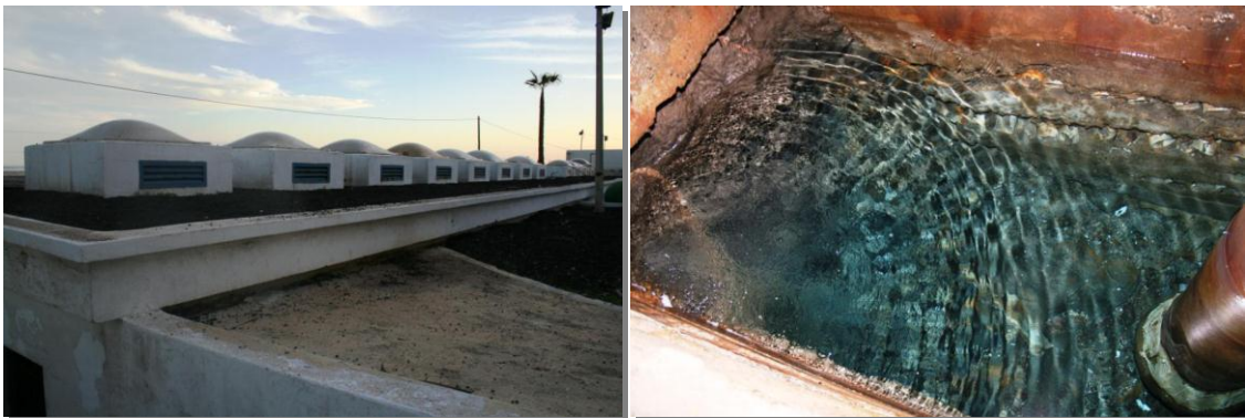
Figura 2. Imagen de las cántaras de captación y de uno de los pozos de Lanzarote III
