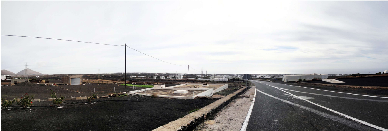
▲ SUBESTACIÓN MACHER, TÍAS [OE_ZI LZ].
