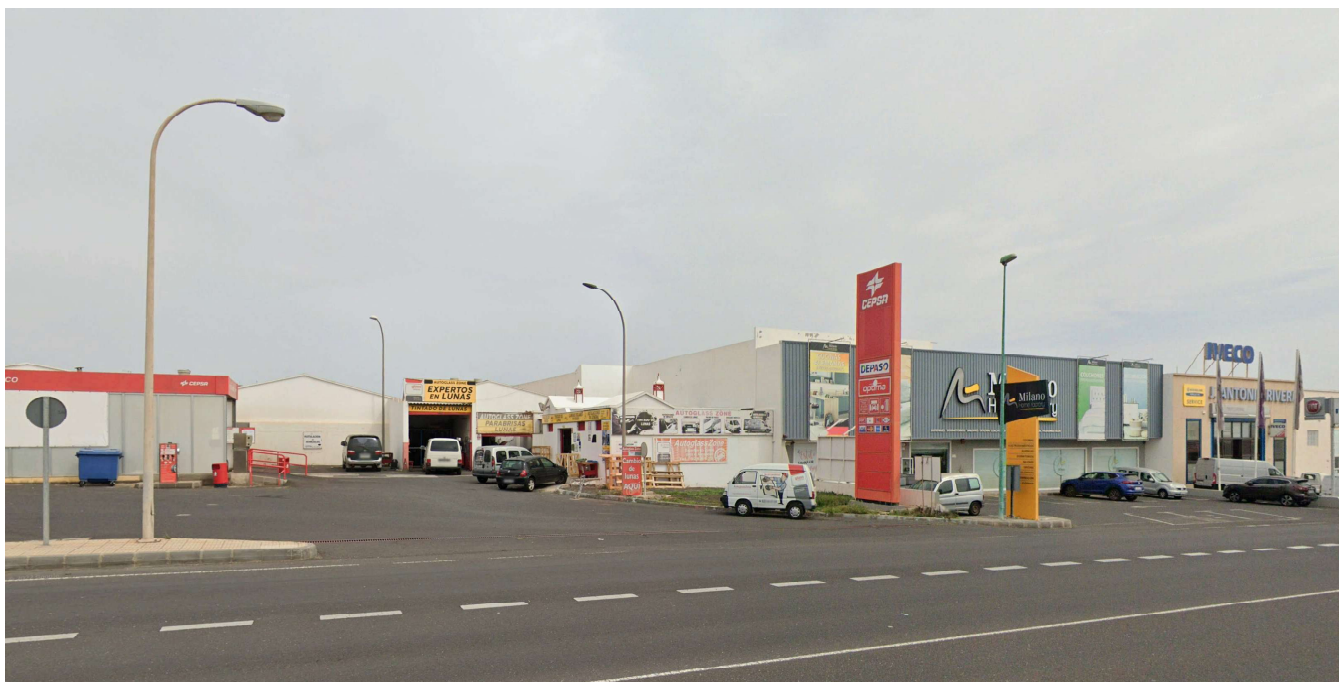
▲ ZONA INDUSTRIAL, ARRECIFE
