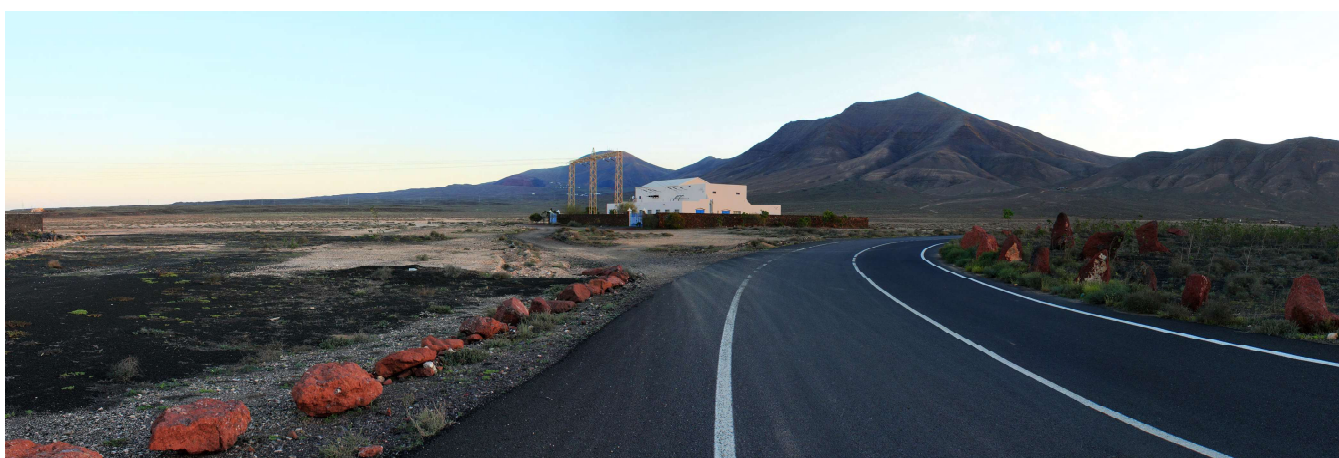
▲ SUBESTACIÓN PLAYA BLANCA, YAIZA
