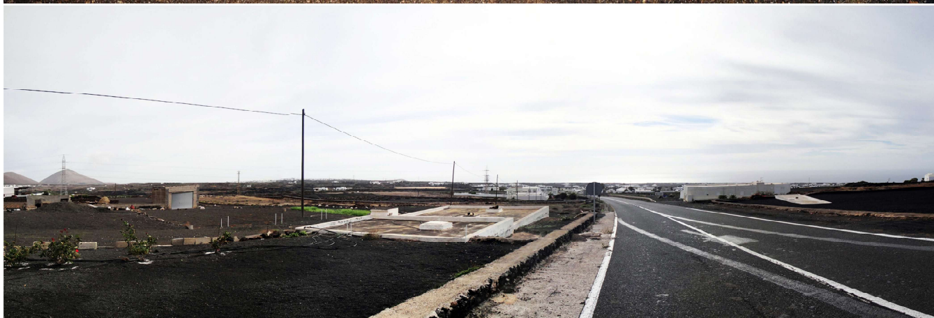
▲ SUBESTACIÓN MACHER, TÍAS
