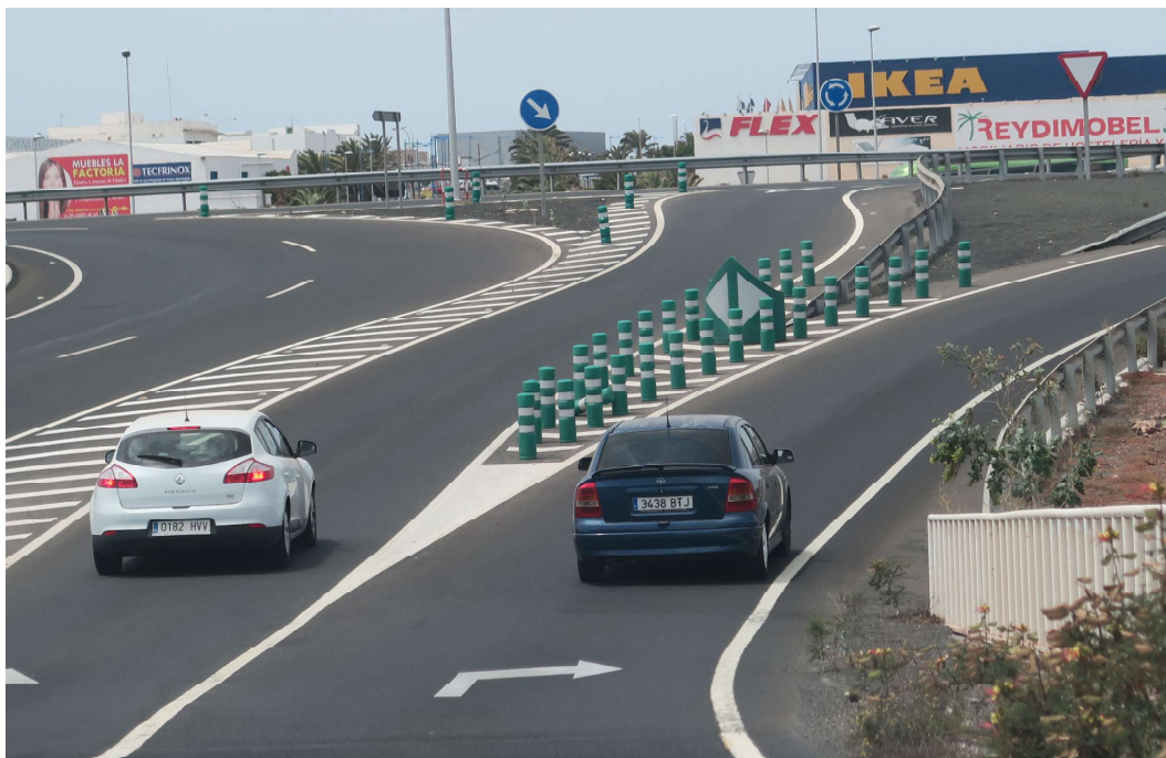
▲ ZONA INDUSTRIAL, ARRECIFE
