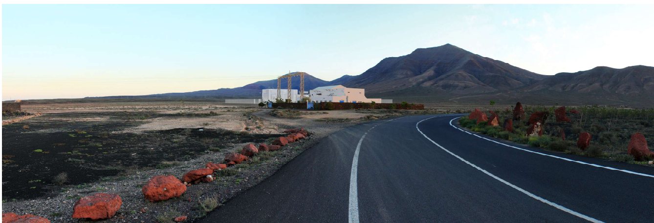
▲ SUBESTACIÓN PLAYA BLANCA, YAIZA [OE_ZI LZ].
